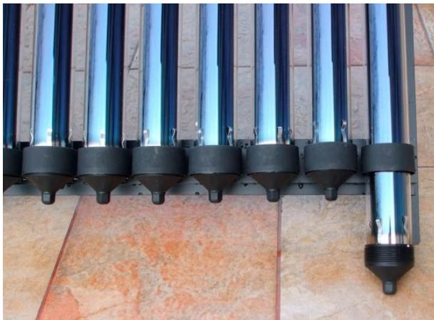
9. Montujemy plastikowe uchwyty do rur próżniowych. Wykręcamy wszystkie kapturki aby pozostały same obejmy. Najpierw wsuwamy górną część obejmy w element **3** W dolnej części obejmy ściskamy palcami zatrzaski i wsuwamy w dolny otwór. Element powinien się zatrzasknąć.
